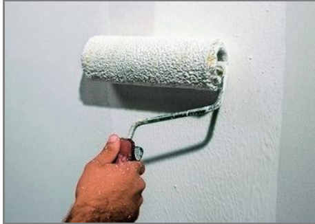
Step 1 - Start applying Primus Sabbia
